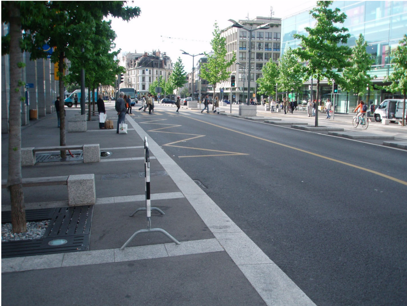
Avenue Général-Guisan, Vevey: 34'000 DTV, Bus- und Veloachse, wichtige Fussverbindung, Einkaufsstrasse, etwa 30m Strassenraumbreite Fassade zu Fassade (Bild vdw)
