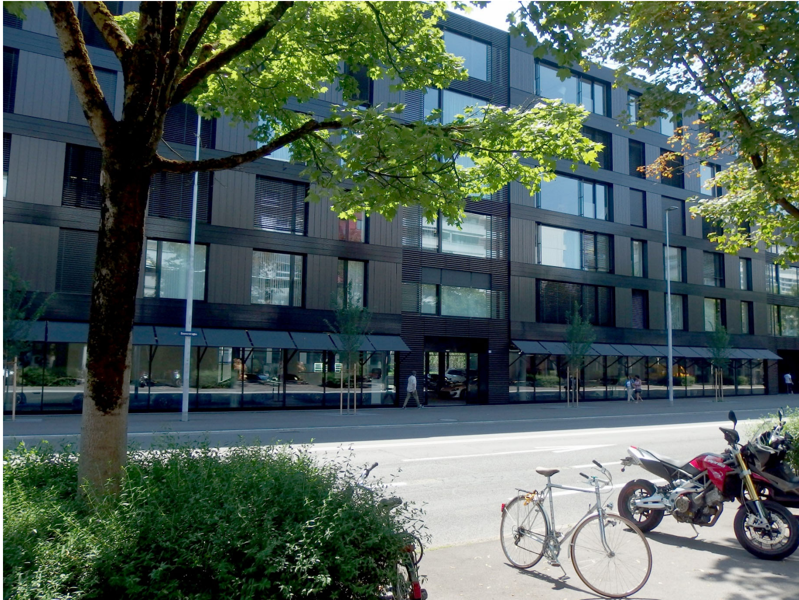
Baarerstrasse, Zug: Einfallsachse, 15-20'000 DTV, etwa 25m Strassenraumbreite (Bild vdw)
